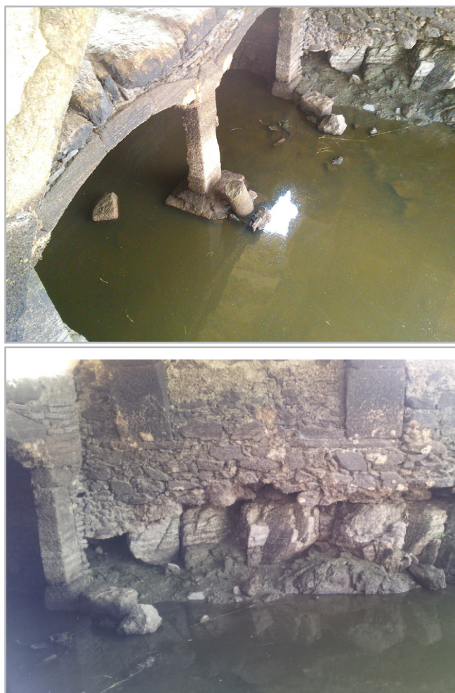
Figura 9.- Estructura de entreplanta y arranque de los arcos de la nave desde la roca. Fuente: Elaboración propia
